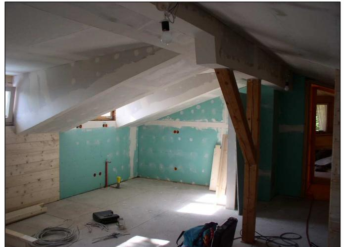
Der Innenausbau mit Rigips an den Wänden und Hamberger Parkett am Boden
