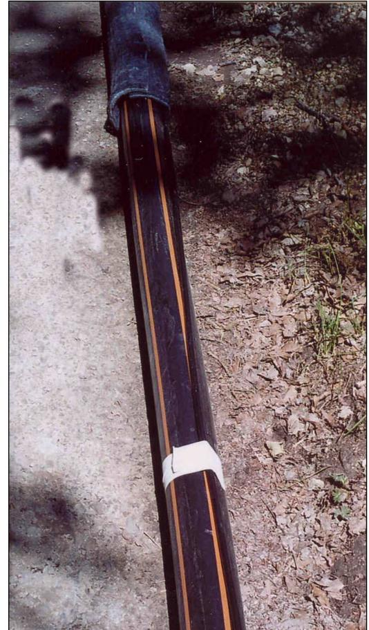
Das Telefonkabel wurde an das Abwasserrohr gebunden, beides mit 15 mm Vlies umhüllt. Für das Rohr zur Wärmeisolierung; beim Telefonkabel erspart man sich die Sandbettung.
