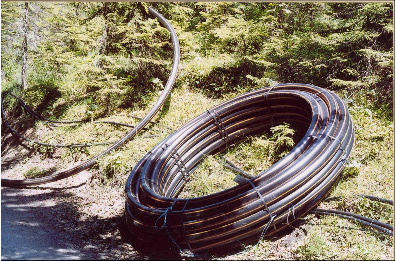
Das Abwasserrohr PE 100 90 x 8,2 mm
