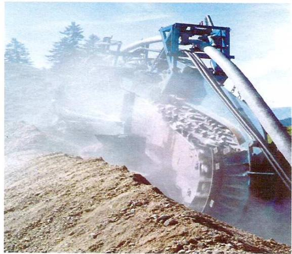
2002 Anschluss an öffentliche Stromversorgung Kabelgraben mit Strom, Telefon- und Abwasserleitung
