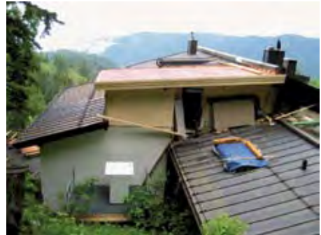
Ausbau einer Dachgaube im 2. Stock
