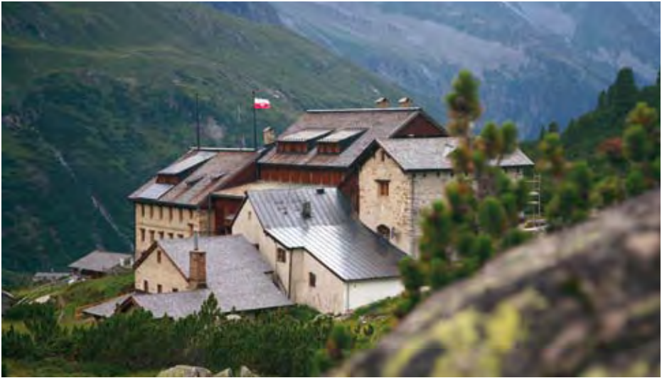
Der verschachtelte Gebäudekomplex der Berliner Hütte
