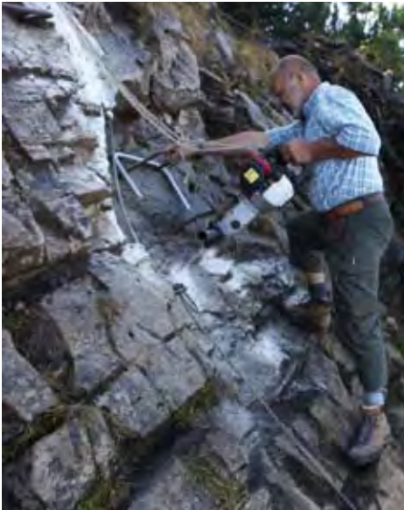
Die neue Benzinbohrmaschine im Einsatz am Kleinen Traithen
