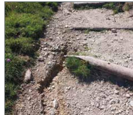
Damit der Weg auch weiterhin begehbar bleibt, haben wir das Wegstück mit zusätzlichen Holzstufen stabilisiert. Jede zusätzliche Stufe verhindert, dass der Wegebelag bei Regen weiter weggespült wird und sich der Weg weiter in den Boden gräbt. Mit den Stufen bleibt der Wegebelag auf dem Weg und der Weg bleibt begehbar. Vielen Dank den hilfsbereiten Wanderern, die uns bei den Wegebauarbeiten mit dem Hinauftragen der Holzstangen tatkräftig unterstützt haben.
